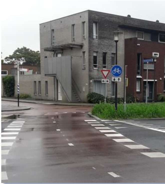
pijlen op onderbord verkeerd
