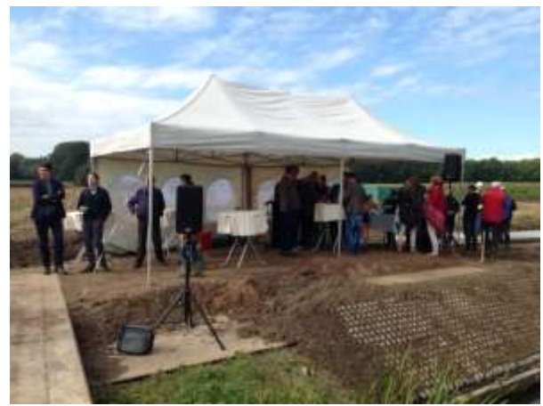
De voorbereidingen voor plaatsen van brug 1
